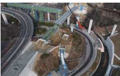
姫路鳥取線 播磨新宮IC工事状況
