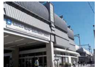
連続立体交差事業 阪神電鉄鳴尾駅付近 (西宮市)
