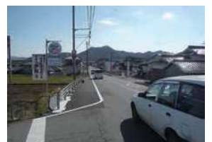
路肩拡幅 県道 高砂北条線(加西市)
