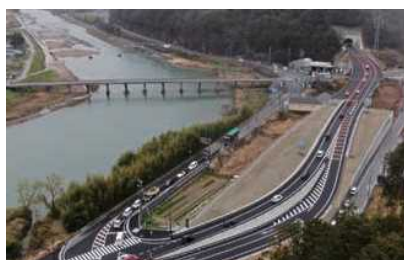
国道175号西脇北バイパス 大伏ランプ付近（西脇市）
