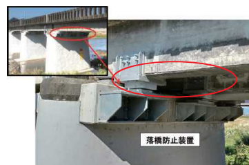
県道 甘地停車場線市川新橋（市川町）
