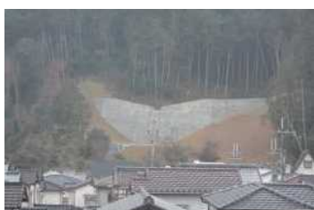
杉之内中谷川2 砂防堰堤 (姫路市)
