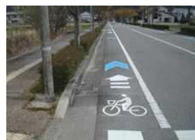
矢羽根型路面標示 県道 多可柏原線(多可町)
