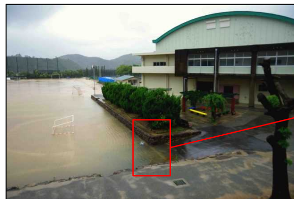
貯留状況(平成30年7月6日12時撮影)
