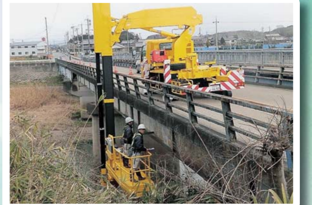
橋梁点検 高砂加古川加西線 原橋(加西市)
