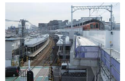
阪神電鉄鳴尾駅付近 連続立体交差（西宮市）
