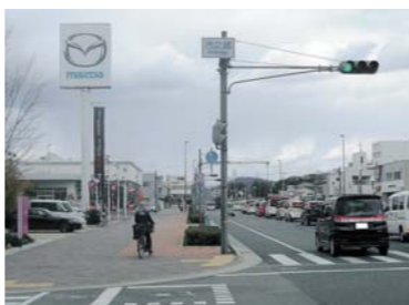
無電柱化による景観形成 都市計画道路 大日線(姫路市)
