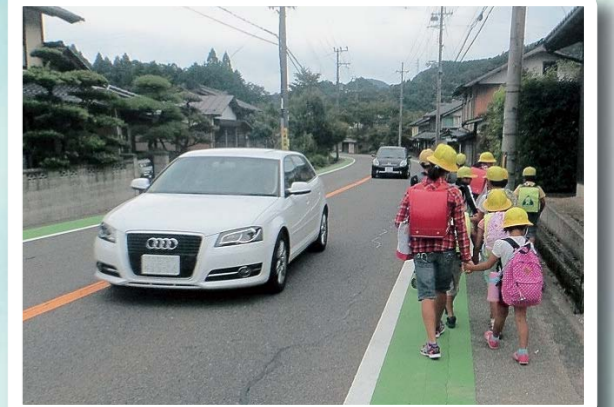
路肩のカラー舗装 国道482号(豊岡市)
