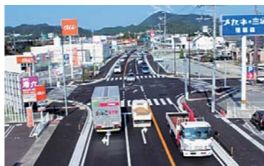
右折車線の設置 県道 三木穴栗線 南田原交差点（福岡町） 【最大待ち回数 3回→1回】
