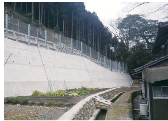
急傾斜地対策 日見谷地区(宍粟市)
