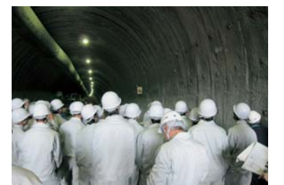
建設業魅力アップ協議会 県内土木系の高校生を対象とした現場研修会(新名神高速道路)
