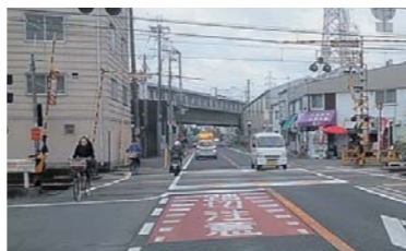
踏切内の車両閉じ込め事故防止対策（カラー舗装、注意喚起文字等の設置） 県道 大阪伊丹線 前畑踏切（尼崎市）
