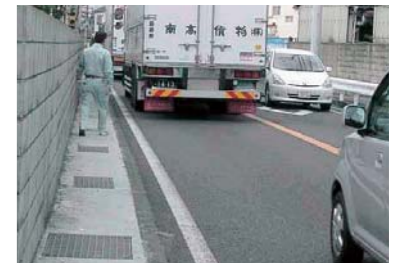
即効対策 側溝の蓋がけ 県道 明石高砂線（播磨町）
