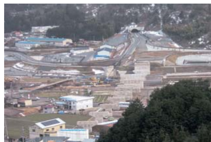
北近畿豊岡自動車道 八鹿日高道路(養父市)
