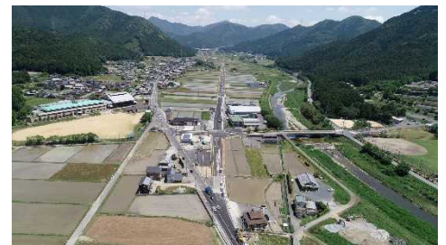
国道427号豊部バイパス
