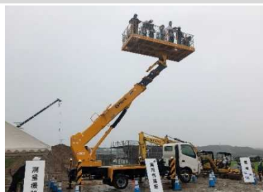
北播磨インフラツアー（東播磨道工事現場）
