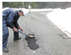
どろろ 道路パトロール
