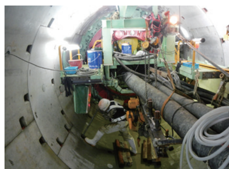
(シールド機内部と組み上げられたセグメント)
