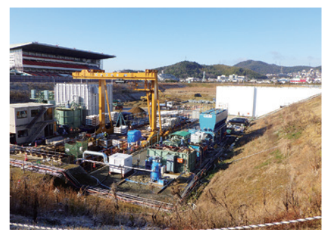
(調節池内に設けられたシールド発進基地)
