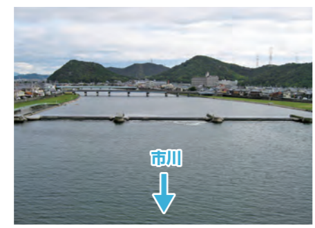
市川潮止堰(ゴム引布製起伏堰)
