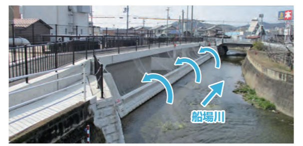
分水施設(船場川から分水するための横越流堰)
