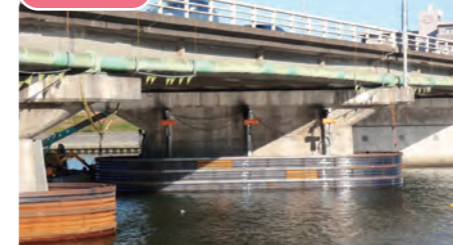
(国)250号 汐見橋 耐震補強工事 (姫路市飾磨区西浜町)
