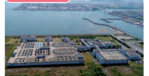
揖保川浄化センター設備補修工事 (姫路市網干区網干浜)
