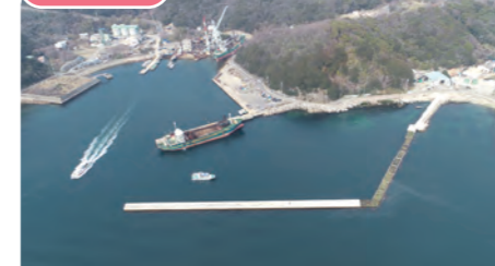
家島港手地区 東護岸整備工事 (姫路市家島町宮)
