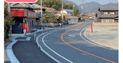
(一)西脇八千代市川線 歩道設置工事 (神崎郡市川町上瀬加)
