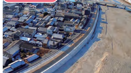
(二)市川 護岸整備工事 (姫路市花田町高木)
