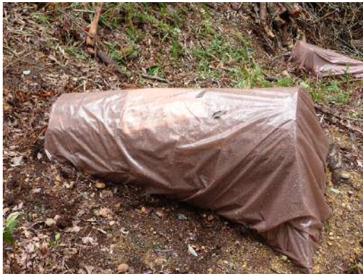
伐倒駆除（くん蒸） 伐倒木に薬剤を散布した後、 ビニールシートで覆う 三木市 三木山森林公園
