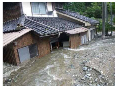
異常出水による土石流で人家が被災（朝来市佐養）
