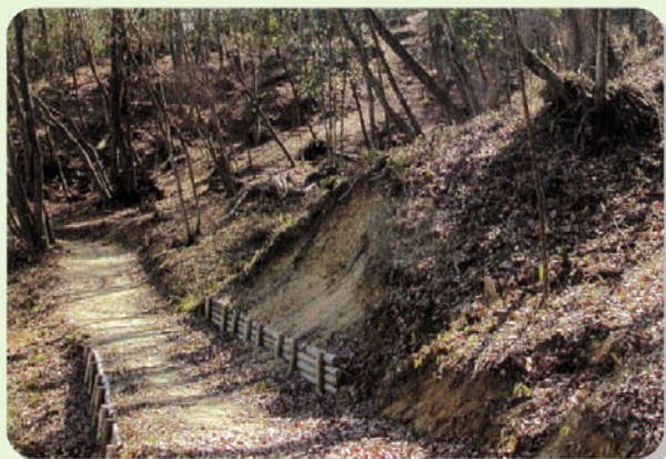
▲ 巡視にも活用する管理歩道
