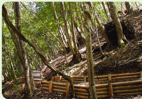
▲ 柵工（表土の流出を留める簡易な防災施設）
