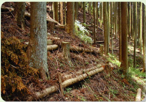
▲ 間伐材を利用した土砂流出を防ぐ土留工の設置
