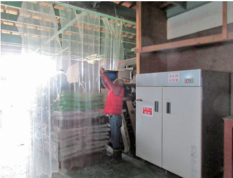
倉庫内に鳥等が侵入しないようにカーテンを設置
