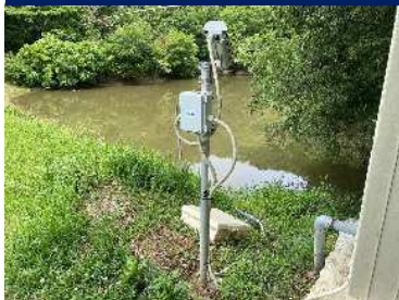
土中立込み基礎ブロックを埋設
