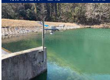
既存構造物に基礎プレートで固定
