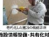
老朽化した施設の機能診断
