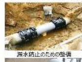
漏水防止のための整備
