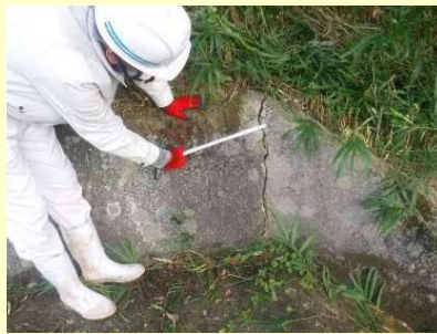
ひび割れ箇所の確認
