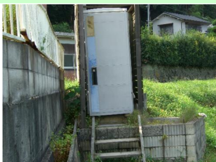
簡易トイレの設置
