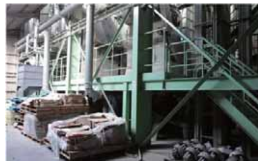
ライスセンター (右) 内部
