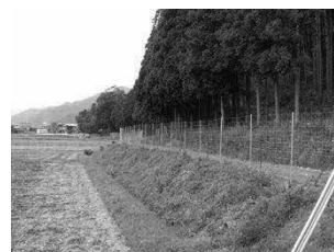
金網柵の設置状況（多可町）
