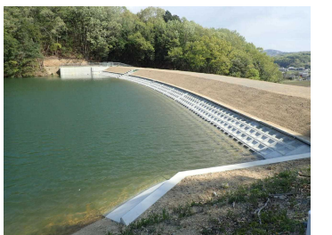
漏水・耐震対策を実施したため池(三木市)
