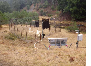
遠隔監視・操作が可能な捕獲施設
