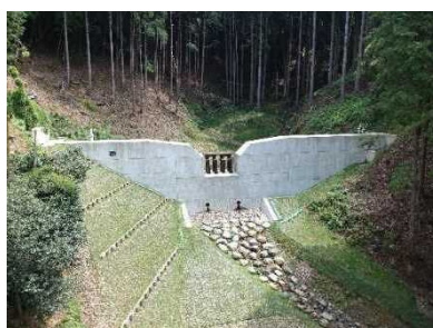
ひょうご式治山ダム（豊岡市）
