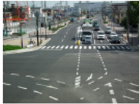
(都) 尼崎宝塚線 (※完成済み工区)
