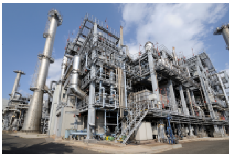
兵庫東流域下水汚泥広域処理場
