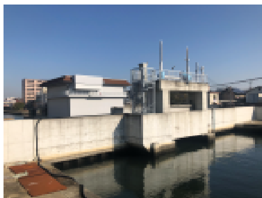
(二) 洗戎川 (水門・排水機場)
