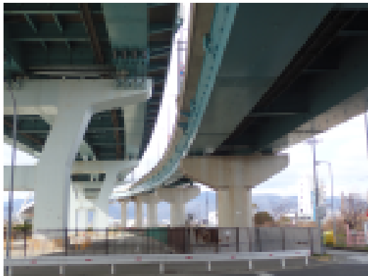
(一) 芦屋鳴尾浜線 (西宮港大橋)
