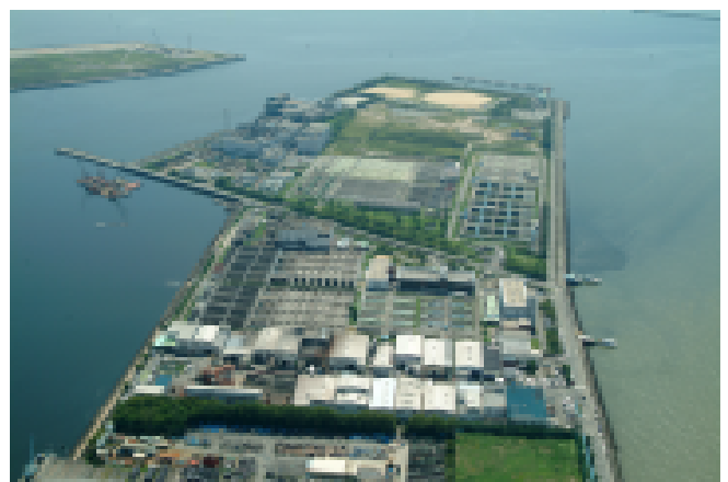
武庫川下流流域下水道 兵庫東流域下水汚泥広域処理場
