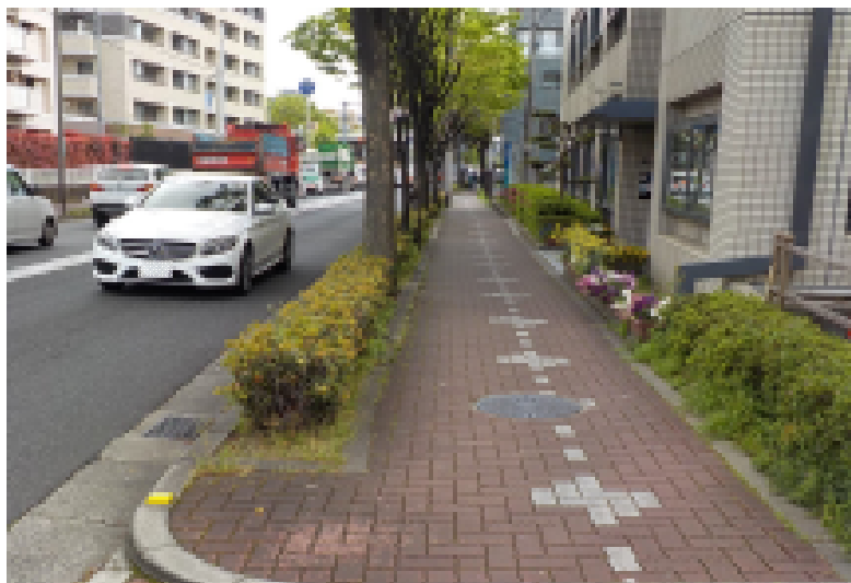
(主) 芦屋停車場線（電線共同溝、自転車通行空間整備）
