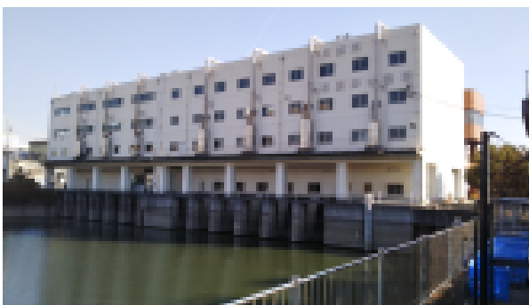
(一) 庄下川（松島排水機場）
