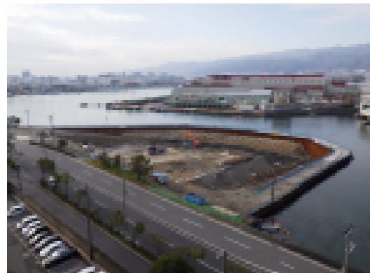
(二) 新川・東川 (水門・統合排水機場)
