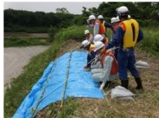
シート張り工法
