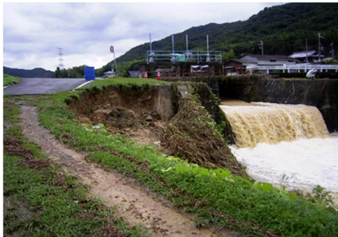
菖蒲池下流の出水状況
