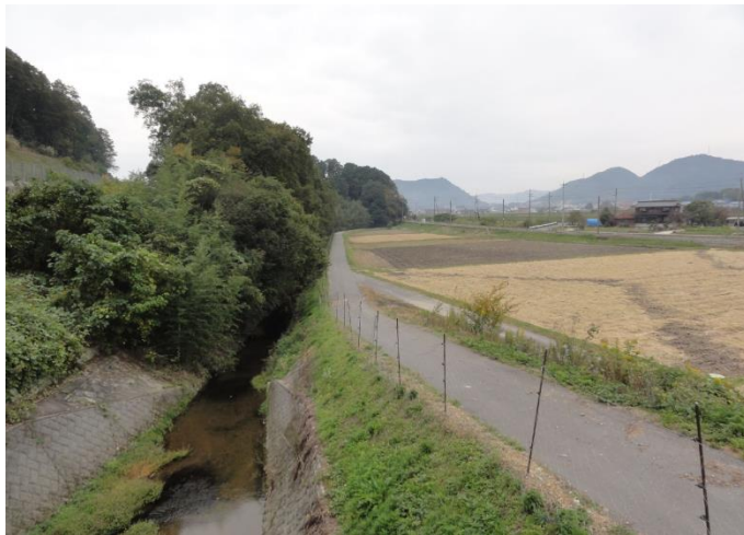
福地川堤防の嵩上げ
