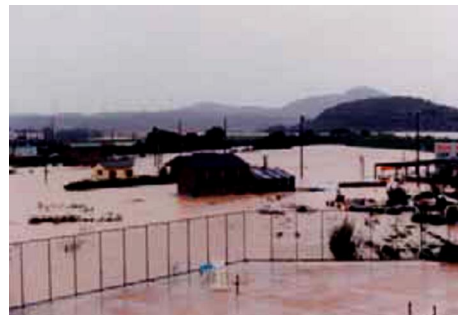
加古川の氾濫(小野市南中学校付近)
