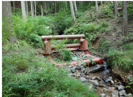
緊急防災林整備 (簡易流木止め工)
