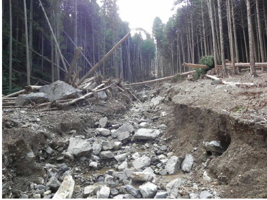
溪流侵食状況 (平成26年8月：丹波市)
