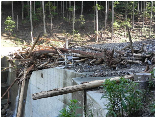
治山ダムによる 土砂・流木捕捉状況
