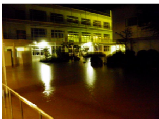
杉原川の氾濫(多可町中町南小学校)
