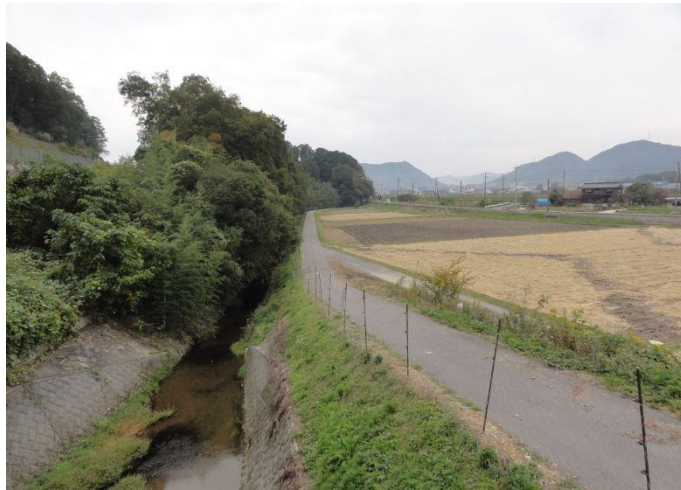
福地川堤防の嵩上げ
