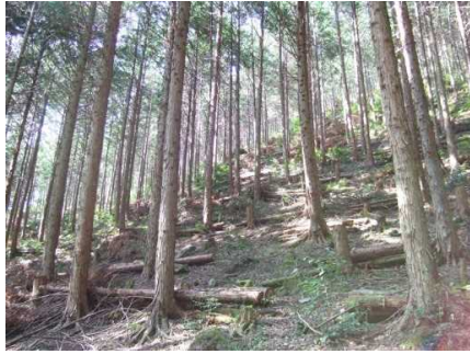
緊急防災林整備（土留工）
