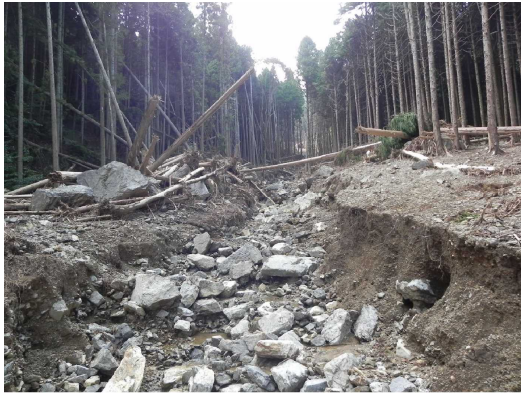
溪流侵食状況 (平成26年8月：丹波市)
