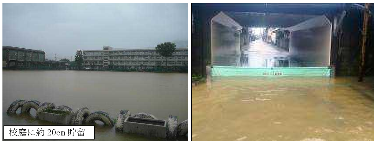
西脇中学校校庭貯留（平成 26 年 8 月）[再掲]
