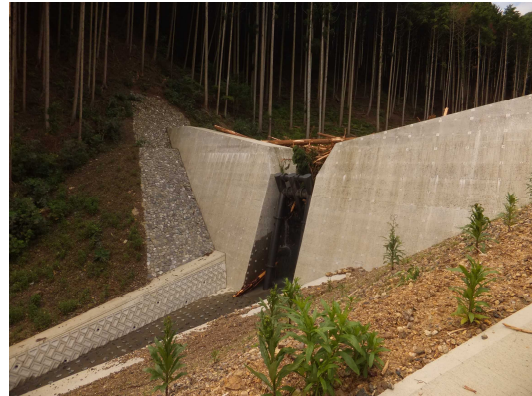
砂防えん堤による 土砂・流木捕捉状況
