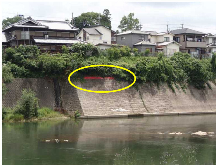
住民の避難の目安となる水位表示板（加東市）
