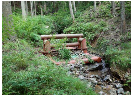
緊急防災林整備 (簡易流木止め工)
