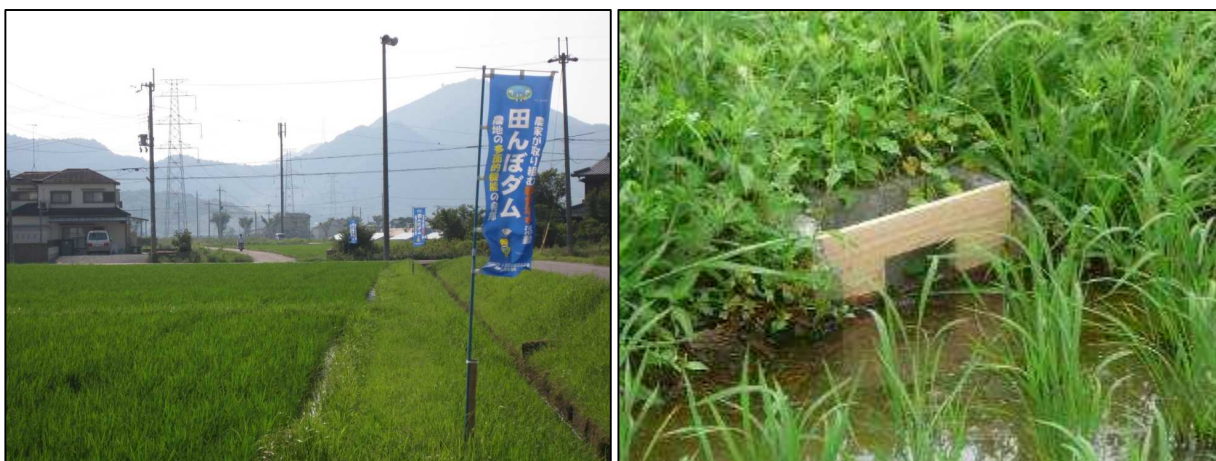
水田貯留の例（「田んぼダム」左写真：加古川市 右写真：小野市）
