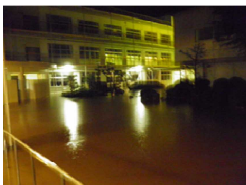
杉原川の氾濫(多可町中町南小学校)
