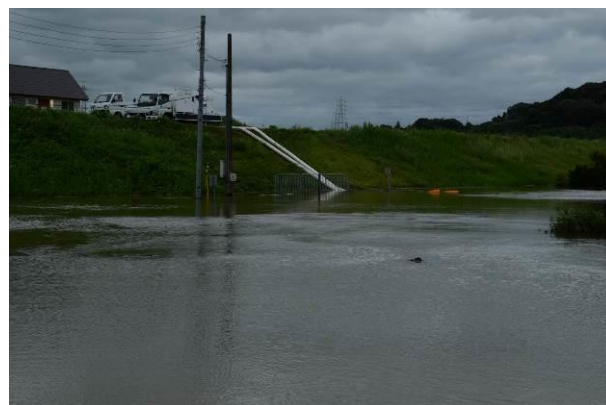
排水ポンプパッケージ車稼働状況
