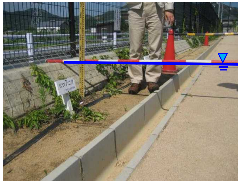
校庭貯留（阿弥陀小学校） [高砂市での取り組み]
