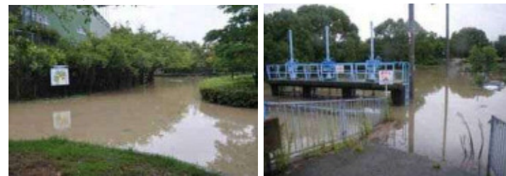
間の川の出水状況写真
