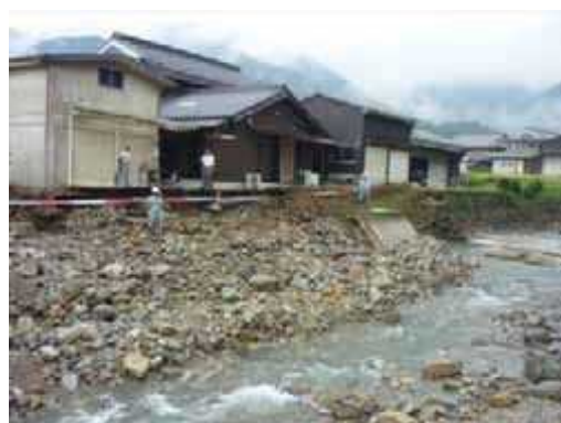
杉原川支川多田川 多田公会堂付近右岸被災状況
