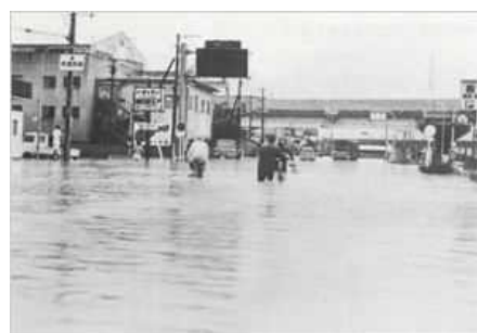
高砂市の浸水状況
