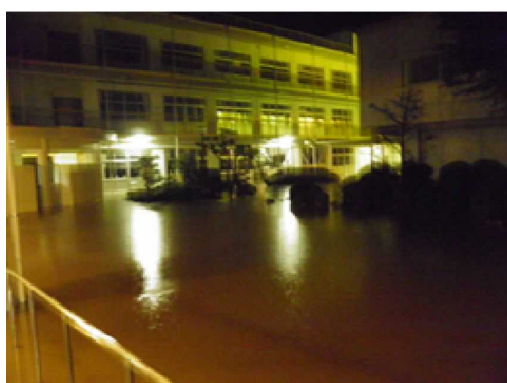
杉原川の氾濫(多可町中町南小学校)
