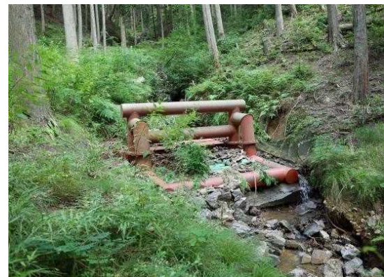
緊急防災林整備 (簡易流木止め工)
