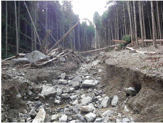
溪流侵食状況 (平成26年8月：丹波市)
