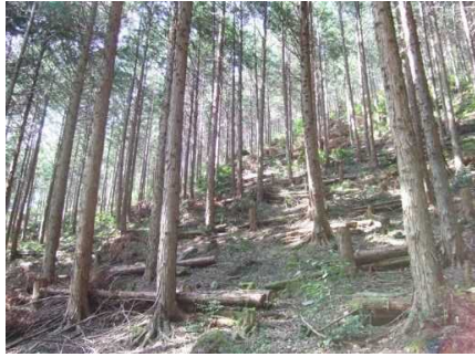
緊急防災林整備（土留工）
