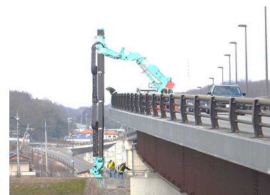
国道 372 号〔加東大橋〕 橋梁点検状況 (加東市)
