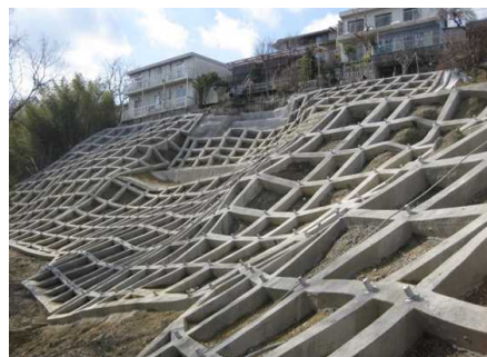
小林地区 急傾斜地崩壊対策 (三木市)
