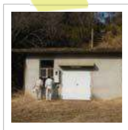
ポンプ場(嬉野ポンプ線)
