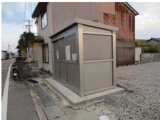
除却後にごみステーションとして活用している事例
