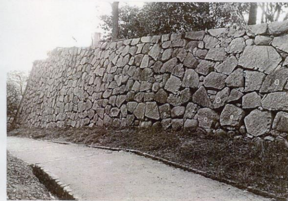
←写真2-1-5 石垣2-11被災前写真 崩壊部分で被災前の写真がある部分は写真を参考に復旧予定概念図を作成する。また写真等がない部分は残存する左右石垣積みの流れを参考にして復旧予定概念図を作成した。 復旧予定概念図
