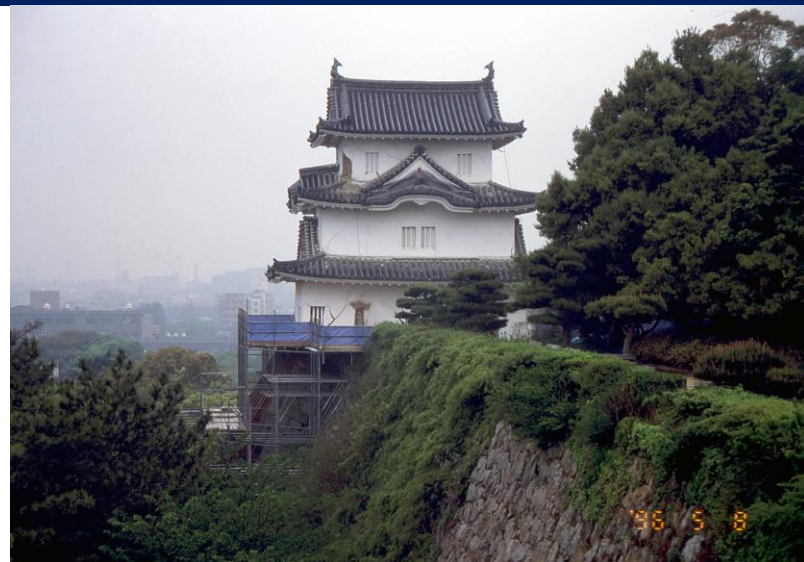
坤櫓作業ステージの設置
