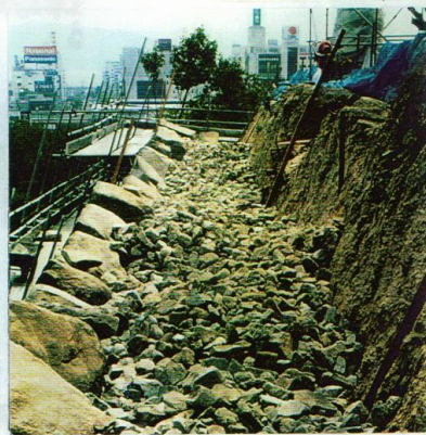
東の丸東側 解体完了後及び施工中
