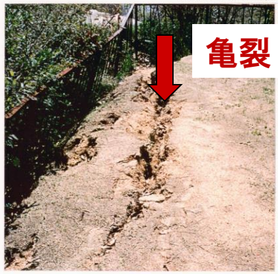
↓写真2-1-2 石垣2-11被災状況 南方天端に生じた亀裂
