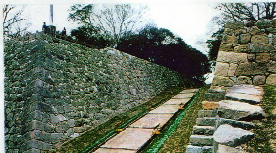
東の丸東側 復旧工事完了 当工区は被災前の写真から ほぼ完璧に旧状に復元できた。
