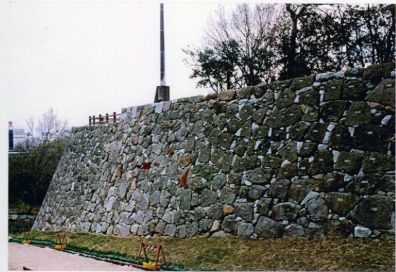
←写真2-1-6 石垣2-11積み直し完了 崩壊部分以外は解体前に全て番付し、写真・図面などに記録し現状復旧した。崩壊部分の石材への番付けは約5m毎にクリット7を設定崩壊位置を区分して崩壊石番付とし旧位置を判定しながら復旧を行った。崩壊部分は復旧予定概念図と記録写真により復旧した。
