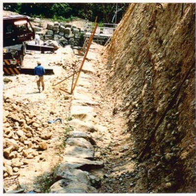
↑写真2-1-3 石垣2-11解体完了状況 崩壊部分の根石は前(東方)にやや迫り出している。
