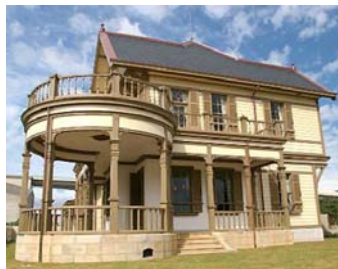
(舞子公園) 文化財(旧武藤山治邸) の保全、活用
