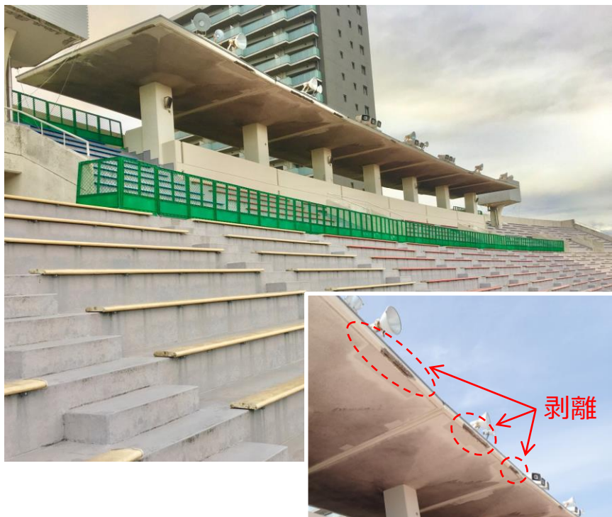
スタンド庇 現況
