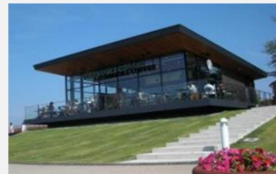
図 設置管理許可事例 (富岩運河環水公園)
