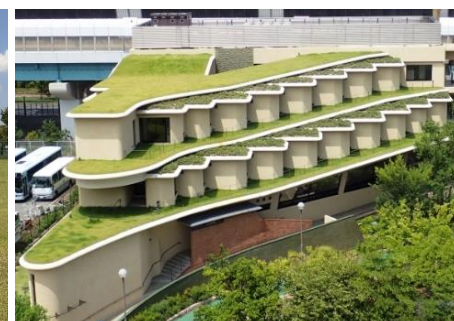
屋上緑化（芦屋市）
