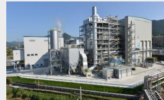
木材等を原料とした燃料で発電を行っている。
