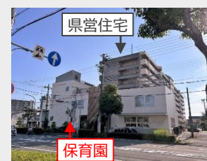
県営尼崎兵つばめ高層住宅（尼崎市）
