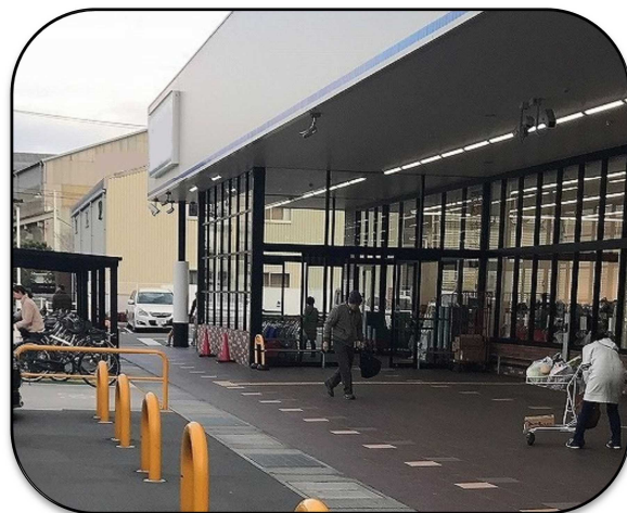
○建物出入口付近のスペース確保
