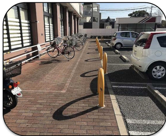
○防護柵の設置
