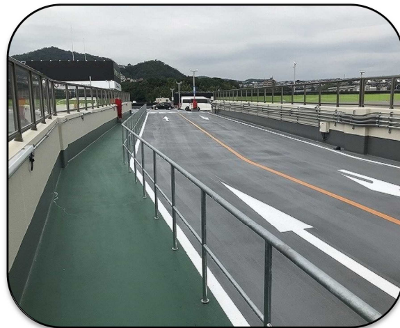
○歩車分離された建物間の連絡通路
