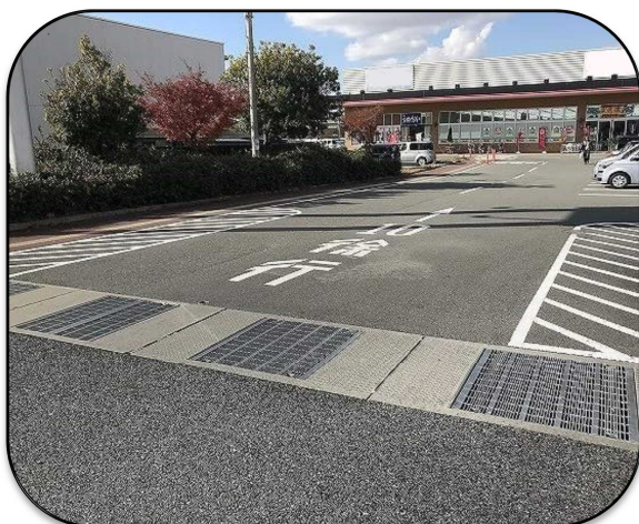
○路面標示による注意喚起
