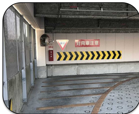
○カーブミラーの設置
