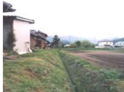
水路沿いに盛土した法面 (山南町草部)
