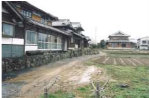
敷地基盤を盛土した石積み (氷上町堀ノ田)
