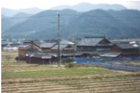
屋根が輻輳し壁面が目立たない在来家屋。彫りが深く陰影がある。
