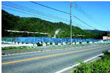
▼ 景観に配慮が望まれる事例
