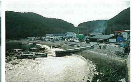
柏の海鮮工場施設
