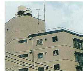
露出した高架水槽
