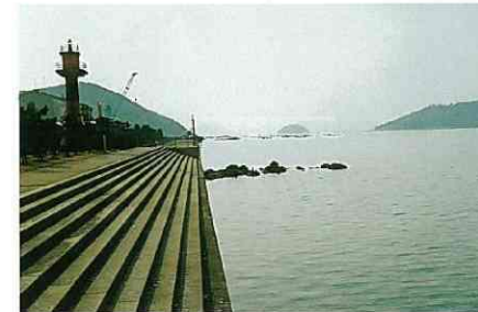
コンクリート製の「雁木」
