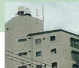
露出した高架水槽
