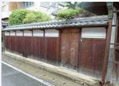
真壁瓦葺き、蕨板張りの塀
