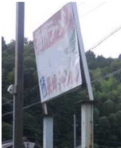
色あせ、退色、変色が著しい建植え広告物。 板面の傾きも補修が必要。
