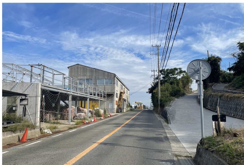
No. B-1 近景_5_現況
