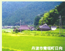
高低差が際立つ 大地に根ざした家屋 丹波市青垣町日向
